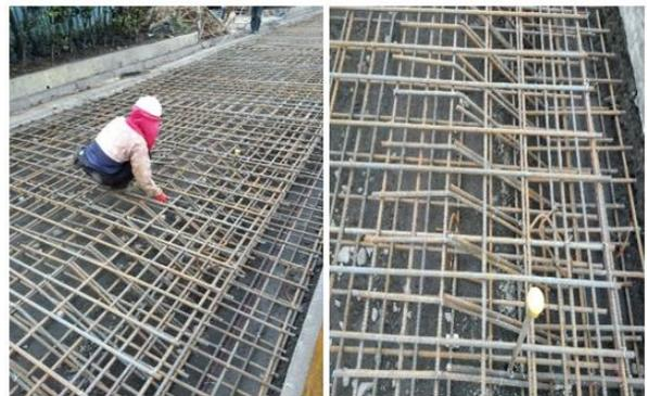
圖 5-13 施工中紀實-支撐基座及鋪面鋼筋組立(北側)
