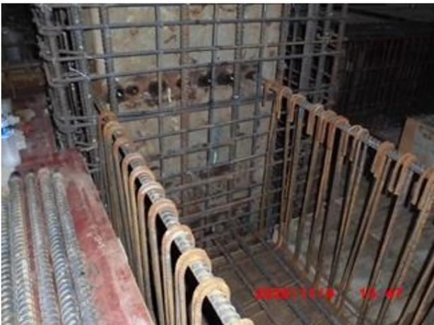
圖 20 SRC 柱與 RC 梁未採取漸進方式接合
