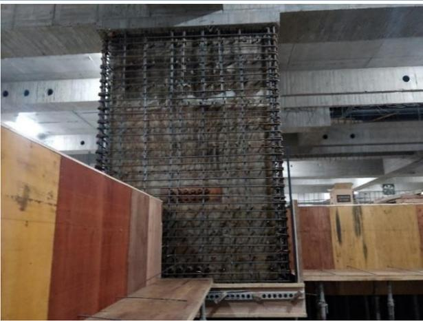
圖 12 RC 梁鋼筋以續接器代替鋼筋直通
