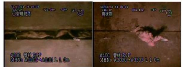
圖 13 (A、B、J、H)管線管線缺失
