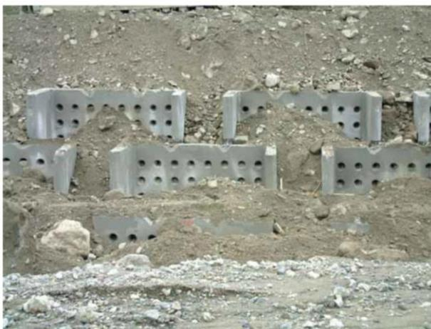
圖 14.C 型護岸回填土方
