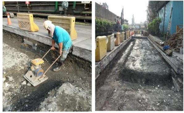
圖 5-11 施工中紀實-基底層整平及夯實(北側)
