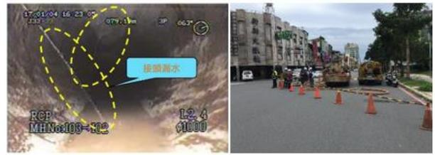
圖 11 I02→I03 管線漏水 圖 12 I03 人孔抽水作業
