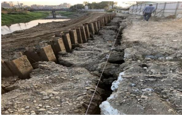
圖 6e 鋼板樁變位量測(變位大於 30 公分)
