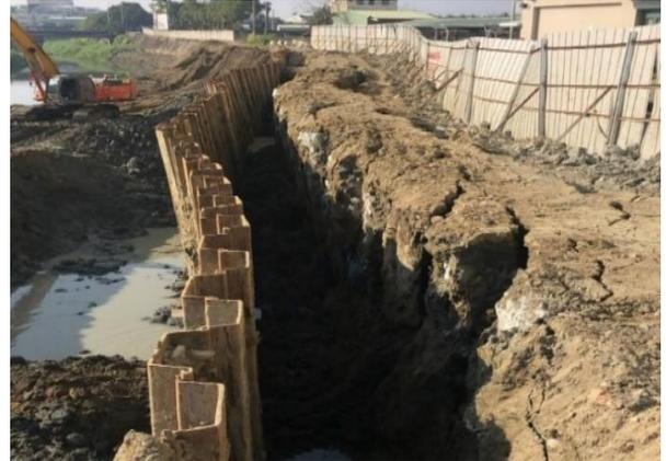
圖 6a 護岸擋土牆基礎(9k+300) 開挖深度 6m 處即發生 13m 鋼板樁倒塌變位
