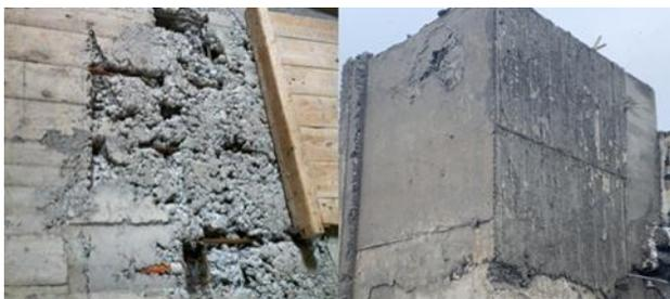
圖 2 受埋置物或鋼筋阻擋混凝土流動及搗實困難產生蜂窩現象
