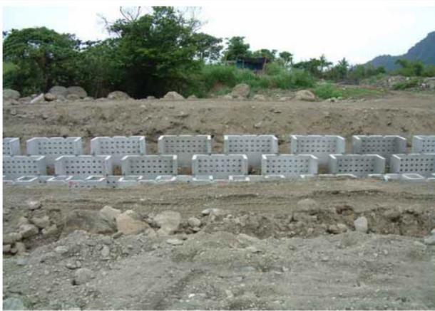
圖 12.C 型單元護岸排列情形
