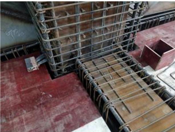
圖 14 SRC 梁鋼筋以續接器續接情形
