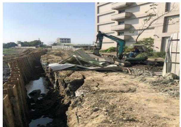
圖 6c 鋼板樁變位處，預壘樁變位，間隔土方下陷嚴重
