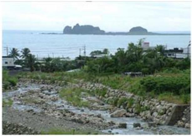
圖 11.美佐呂溪植生復舊照片(完工八個月)
