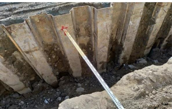
圖 6g 鋼板樁變位量測(大於 1 公尺)
