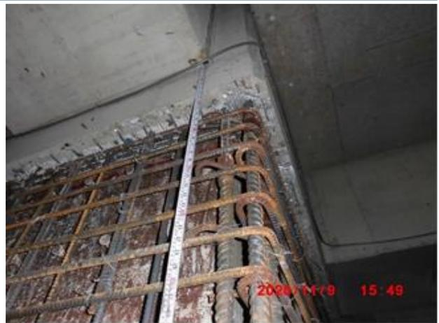
圖 6 柱筋續接位置距梁底 $\leq 500$ mm
