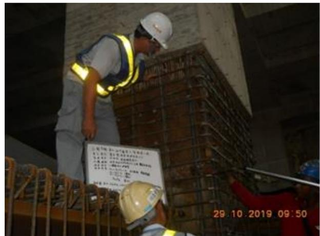
圖 22 監造單位執行鋼筋續接品質抽查驗
