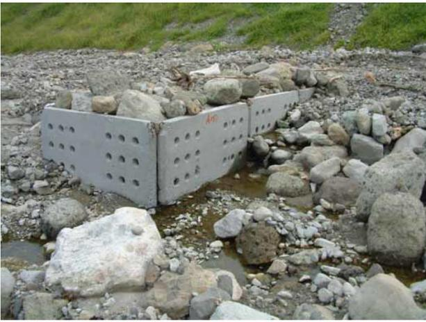
圖 8.T 型單元水制工拋石
