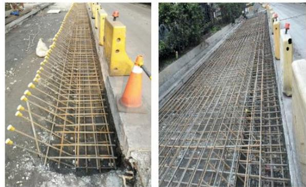
圖 5-12 施工中紀實-支撐基座及鋪面鋼筋組立(北側)
