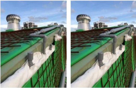
圖 16 分水器      圖 17 回水合流器
