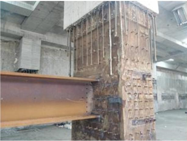
圖 10 輔助主筋因施工造成偏位
