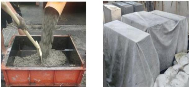
(圖 13) 混凝土現場澆置、養護
