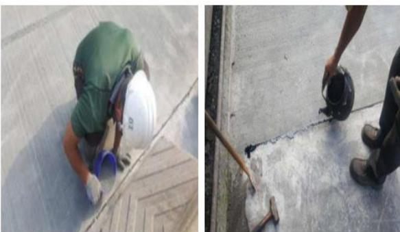
圖 5-18 施工中紀實-無筋接縫(伸縮縫)設置(北側)
