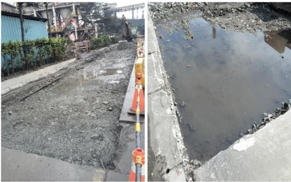
圖 5-7 施工中紀實-基底層長年泡水、積水(北側)
