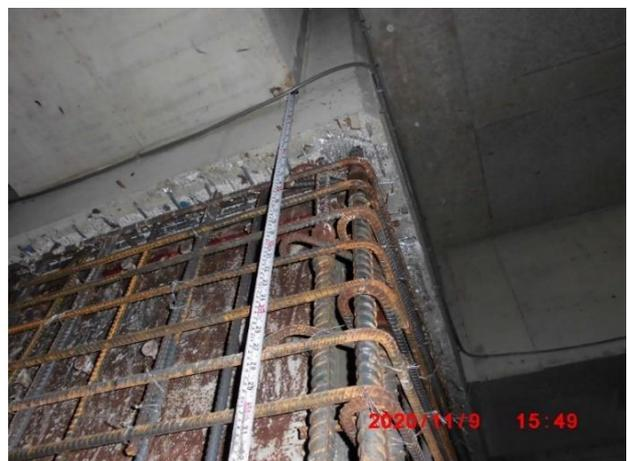
圖 8 輔助筋間距過大之施工品質缺失
