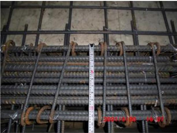
圖 16 梁筋搭接上下配置不易造成間距不足
