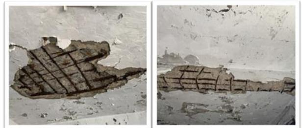
圖 6 鋼筋因銹蝕膨脹造成混凝土塊剝落
