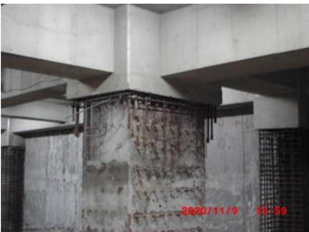
圖 5 柱筋斷點集中於同一斷面
