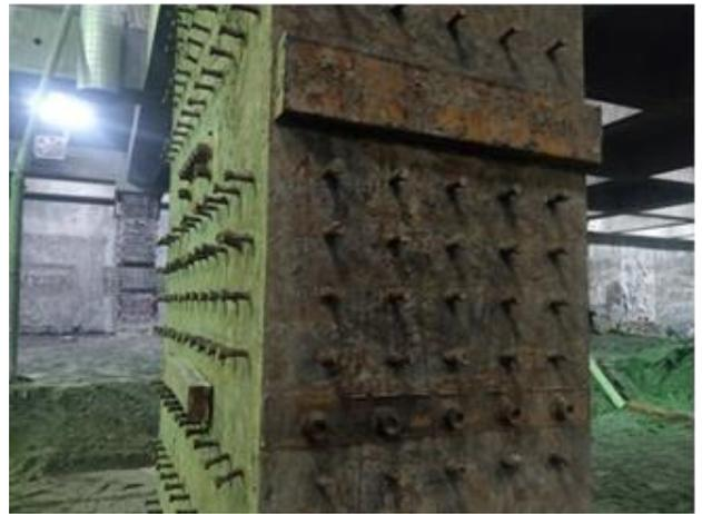
圖 11 開挖過程部分續接器護蓋掉落
