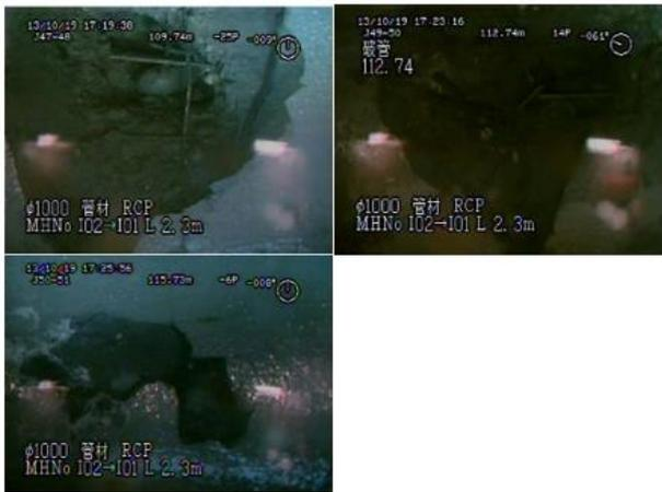
圖 10 I02→I01 管線 3 處破孔
