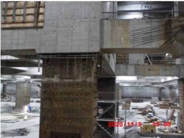
圖 4 柱筋斷點集中於同一斷面
