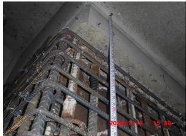
圖 7 柱筋續接位置距梁底 $\leq 500$ mm
