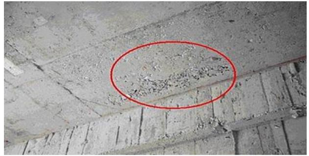
圖 5 不當的拆模造成混凝土表面剝落
