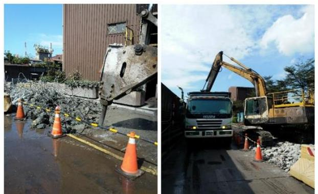
圖 5-6 施工中紀實-1.既有剛性鋪面打除(北側)
