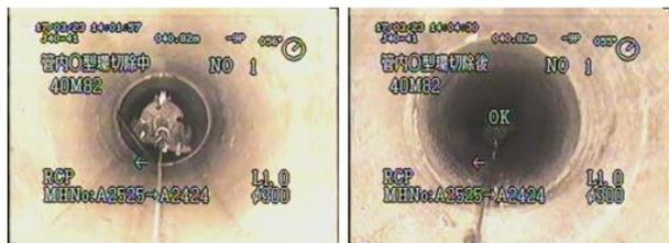
圖 19 管內 O 型環脫落切除
