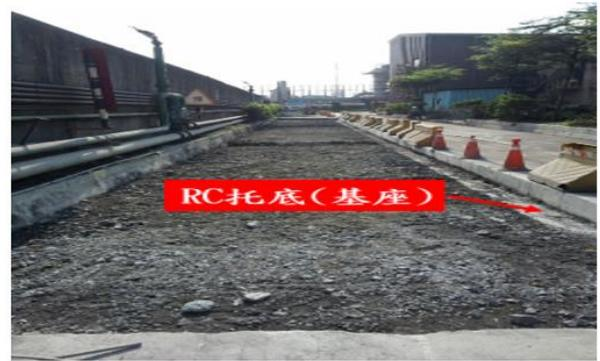
圖 5-19 施工中紀實-托底支撐基座完成照
