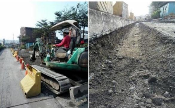
圖 5-10 施工中紀實-基底層開挖支撐基座坑(北側)
