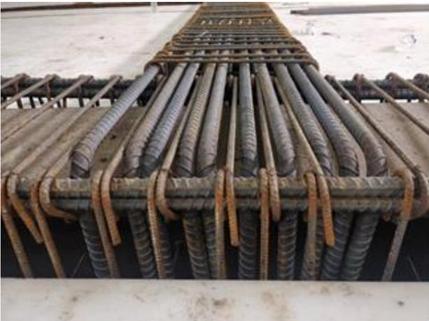
圖 17 梁筋錨定受制大梁箍筋配置不易造成間距不足
