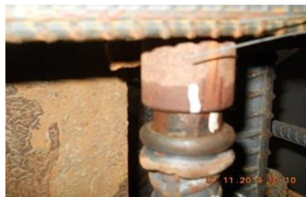
圖 26 監造單位執行鋼筋續接品質抽查驗
