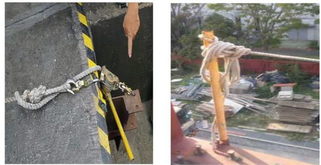
圖 1 水平母索固定端形式[2]
