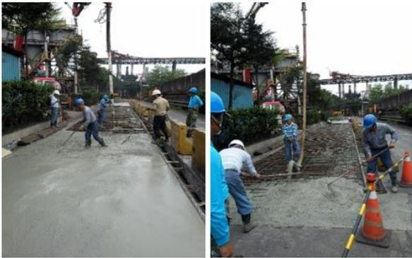
圖 5-16 施工中紀實-280kg/cm<sup>2</sup> 混凝土泵送澆置(北側)
