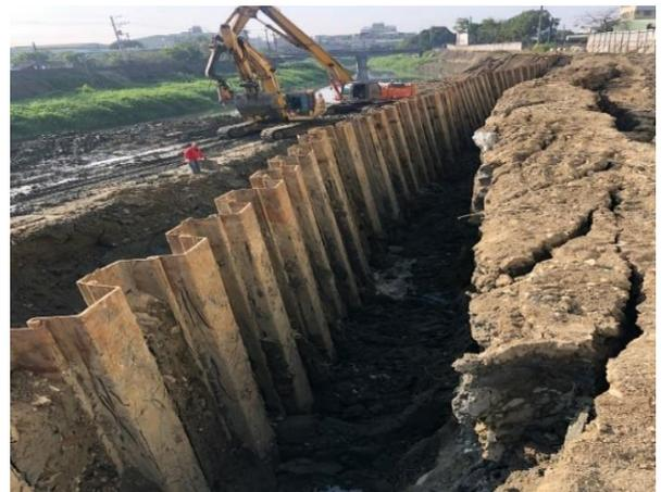
圖 6b 鋼板樁傾斜側向變位，土方下陷
