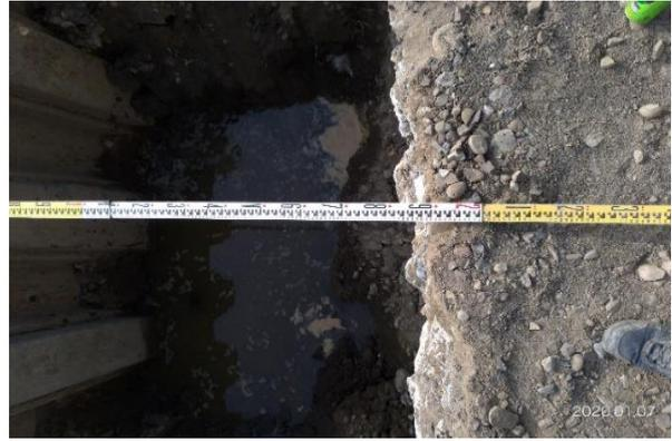
圖 6h 鋼板樁變位量測(大於 1 公尺)
