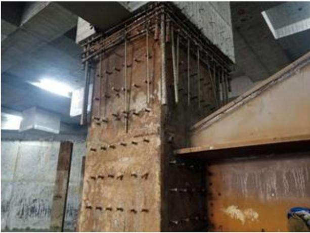
圖 9 輔助主筋因施工造成偏位
