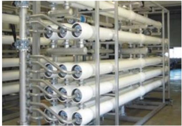
圖 5 RO 膜管殼外觀示意圖
