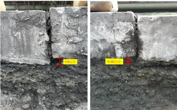
圖 5-8 施工中紀實-另一側鋪面版塊嚴重沉陷、高低差(南側)
