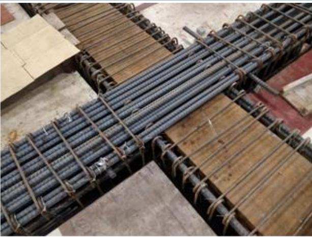
圖 15 梁筋搭接上下配置不易造成間距不足
