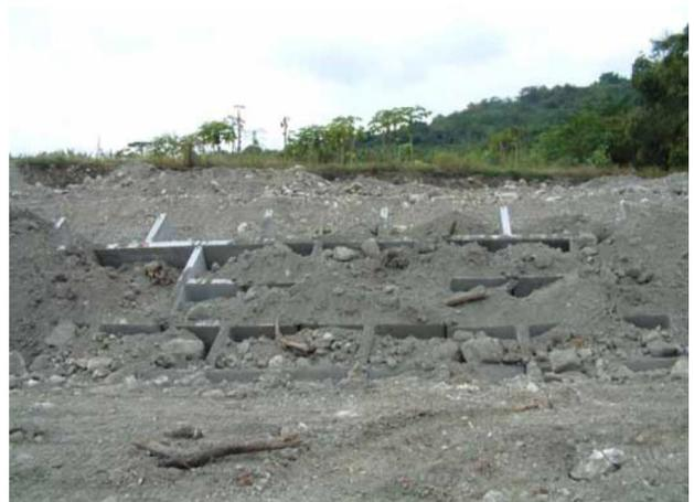
圖 6.T 型單元護岸回填土方
