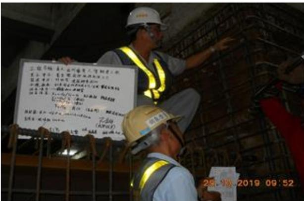
圖 24 監造單位執行鋼筋續接品質抽查驗
