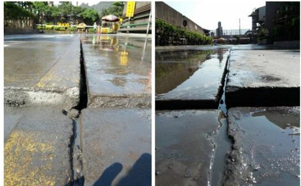
圖 5-5 施工前紀實-剛性鋪面損壞情形
