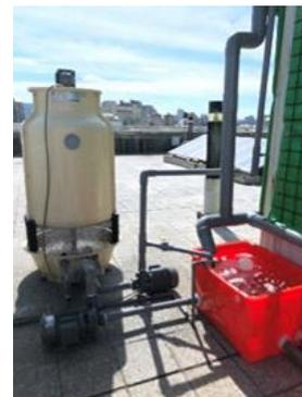
圖 15 冰水機、供水與補水系統
