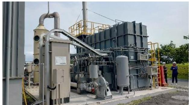
圖 6 宜蘭廠再利用設備-空污防治系統 RTO
