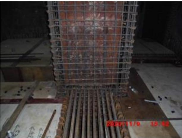
圖 13 RC 梁鋼筋以續接器續接情形
