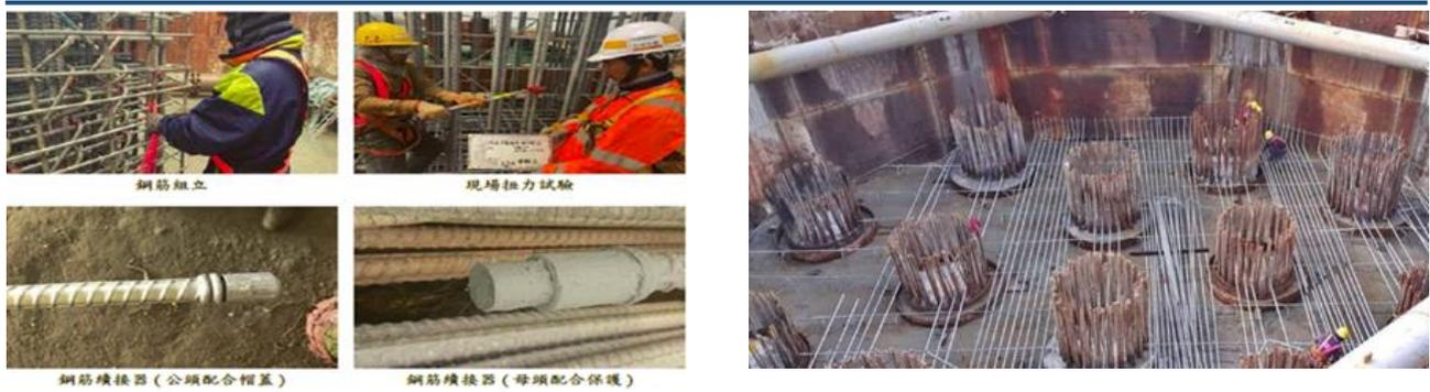
圖 9 金門大橋基礎鋼筋綁紮施工
