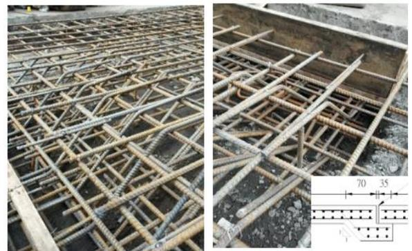
圖 5-14 施工中紀實-支撐基座及鋪面鋼筋組立(北側)
