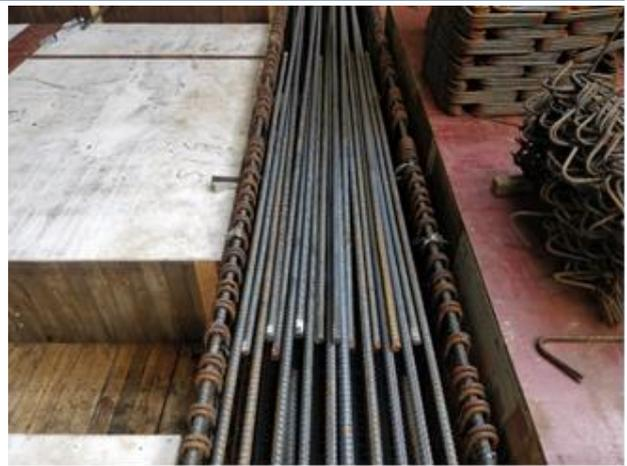
圖 15 續接器鋼筋等長所致於同一斷面搭接
