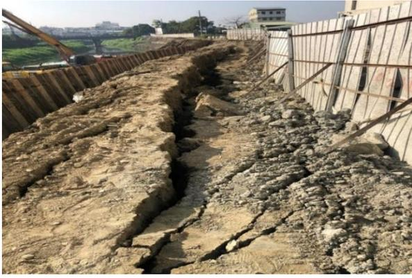
圖 6d 鋼板樁及預壘樁處，側向變位持續增加，土方下陷過大
