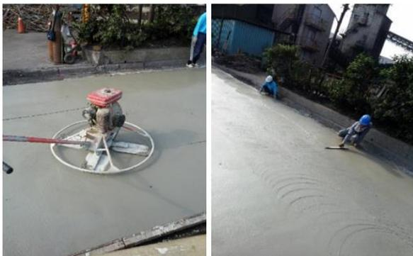
圖 5-17 施工中紀實-鋪面整體表面粉光、修飾(北側)
