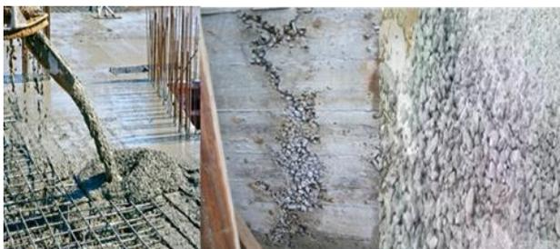
圖 4 不正確的混凝土澆置方式產生析離現象
