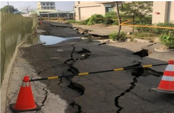
圖 6f 地面龜裂下陷面積持續增加，並產生階梯狀態下陷情形
